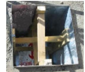
Etayer l'intérieur du caisson avant coulage du béton pour éviter toute déformation de celui-ci.
