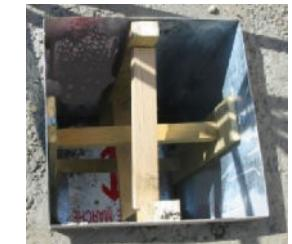
Etayer l'intérieur du caisson avant coulage du béton pour éviter toute déformation de celui-ci.
