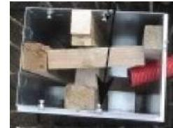
Etayer l'intérieur du caisson avant coulage du béton pour éviter toute déformation de celui-ci.
